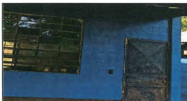
FOTO. Instalacion de puerta de metal de 103 mst x2.06 mst 6
