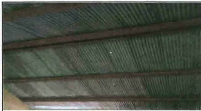
FOTO. Mantenimiento de cubierta de lamina 4
