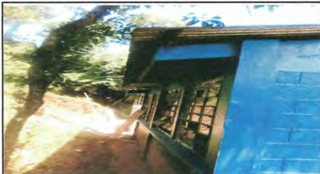
FOTO. Mejoramiento de canales y bajada de agua pluvial lado atrás 7
