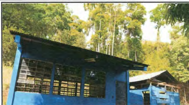
FOTO. Cambio de vidrios por balcon 2
