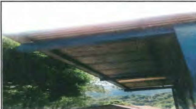
FOTO. Mejoramiento de canales y bajada de agua pluvial enfrente 8
