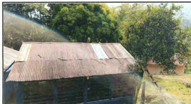
FOTO. Sustitucion de lamina normal por lamina troquelada calibre 26 aluzinc de Aula 3
