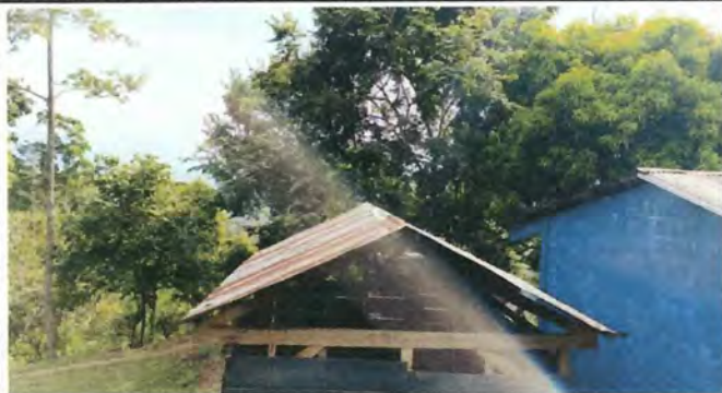
FOTO. Sustitucion de lamina normal por lamina troquelada calibre 26 aluzinc de cocina 1
